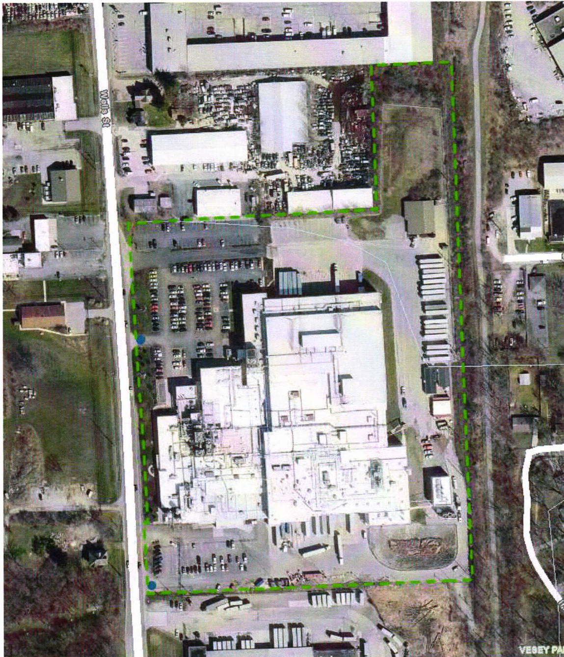
Allen Co. GIS Aerial for Parcel 02-07-26-379-001.000-073
